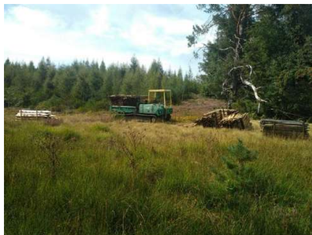
Pose de clôture
