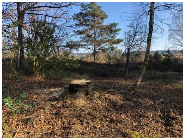
Bûcheronnage de restauration
