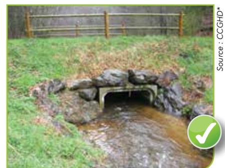
Buse cadre enterrée au 1/3
