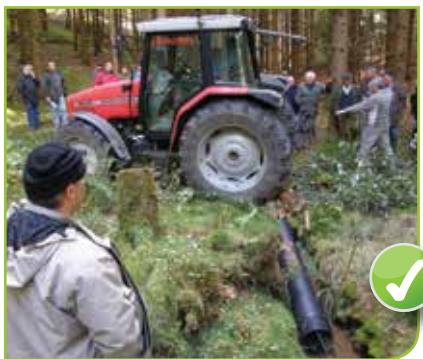
Tube PEHD* recouvert de rondins
