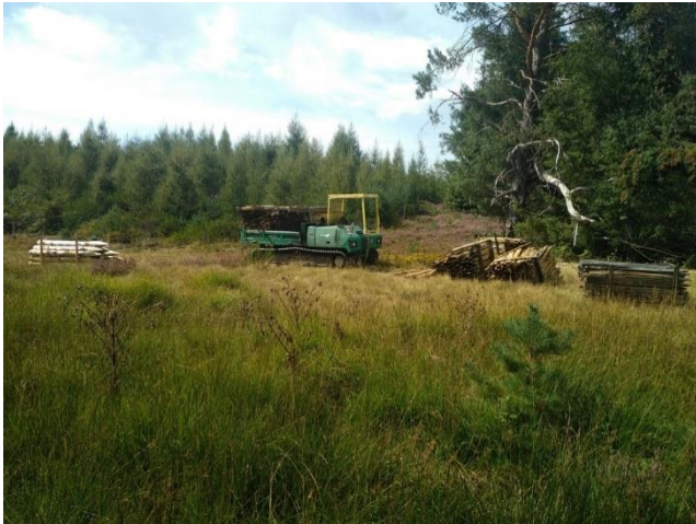
Pose de clôture
