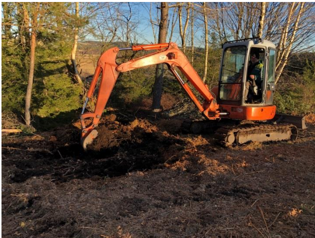
Travaux de décapage
