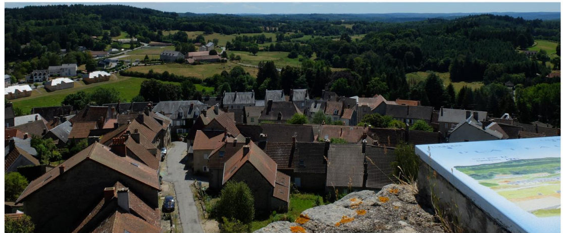
▲ Crocq et ses toitures de tuiles : selon les vues et le type de matériaux les enjeux ne sont pas les mêmes - Il est plus difficile d'intégrer du photovoltaïque sur des toitures en tuile qu'en ardoise (raccord couleur)
