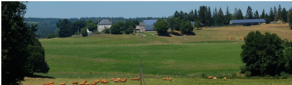
▲ La Navade - Châlons : une envergure en rapport de proportion avec les bâtiments anciens et des teintes sombres qui se fondent dans le paysage.
