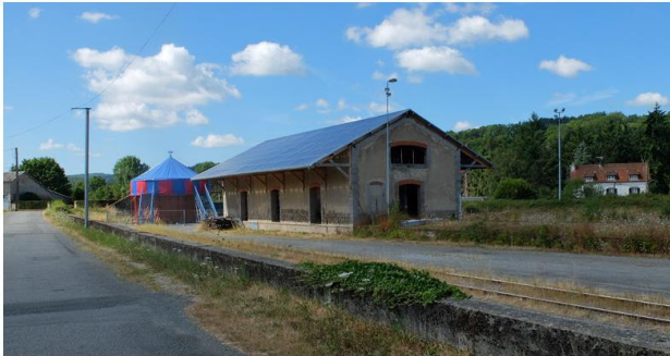
▲ Ancienne gare de marchandise de Felletin : une toiture photovoltaïque bien intégrée
