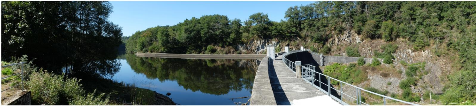
▲ Barrage des Combes sur la Creuse
