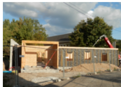
Chantier en cours © PNRML
