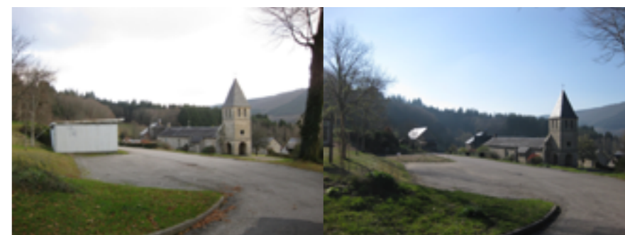
Bourg de Veix : avant et après la démolition de l'ancien préfabriqué © PNRML
