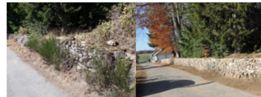
Mur avant et après travaux © PNRML
