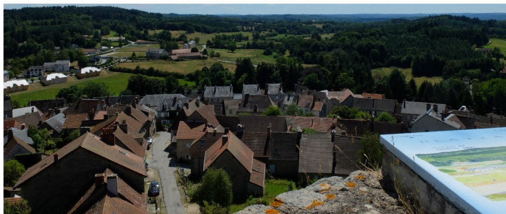
▲ Crocq et ses toitures de tuiles : selon les vues et le type de matériaux les enjeux ne sont pas les mêmes - Il est plus difficile d'intégrer du photovoltaïque sur des toitures en tuile qu'en ardoise (raccord couleur)
