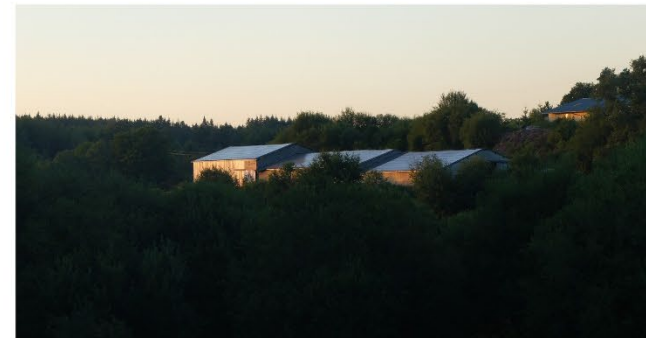
▲ Millevaches : une bonne intégration des volumes bâti permet une bonne intégration du photovoltaïque
