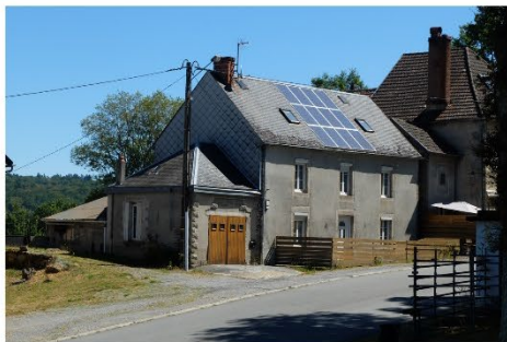
▲ La Courtine - habitat et photovoltaïque
