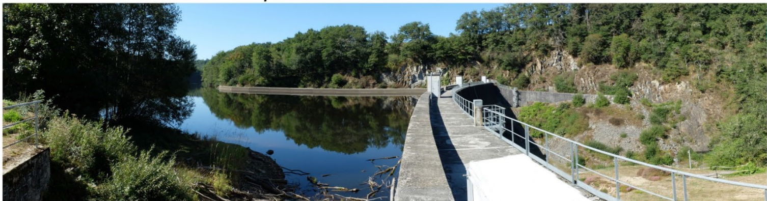
▲ Barrage des Combes sur la Creuse
